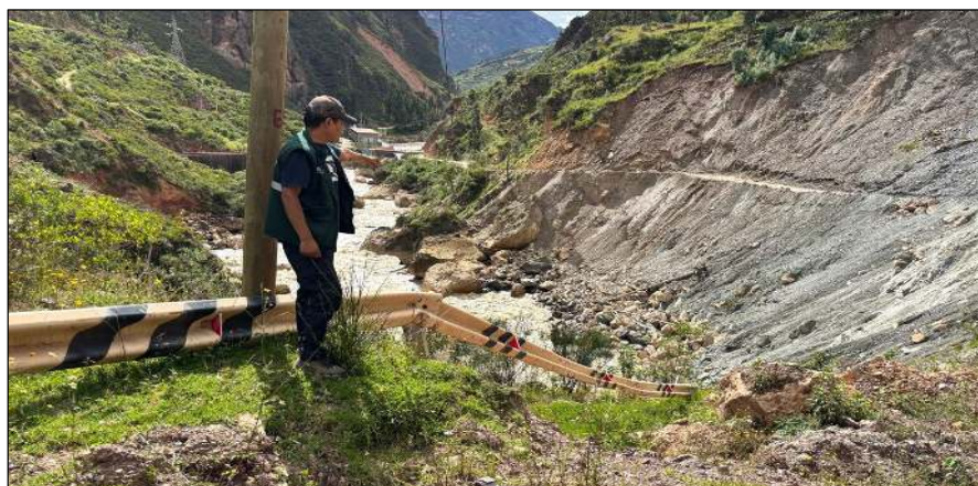
Figura 1. Identificación de punto crítico en margen derecha. Sector localizado en coordenadas E=308322 m, N=8941993 m. Evidencia de socavación y pérdida de estabilidad del terreno. Infraestructura vial en riesgo que conecta con Llata, Miraflores y otros centros poblados.
