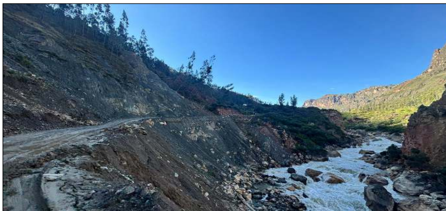
Figura 2. Lecho rocoso del río Marañón. Presencia de material rocoso en el fondo del cauce que aporta estabilidad natural. Potencial aprovechamiento del material existente en el cauce. Ausencia de estructuras de defensa ribereña en margen derecha. Falta de obras de protección frente a procesos erosivos.
